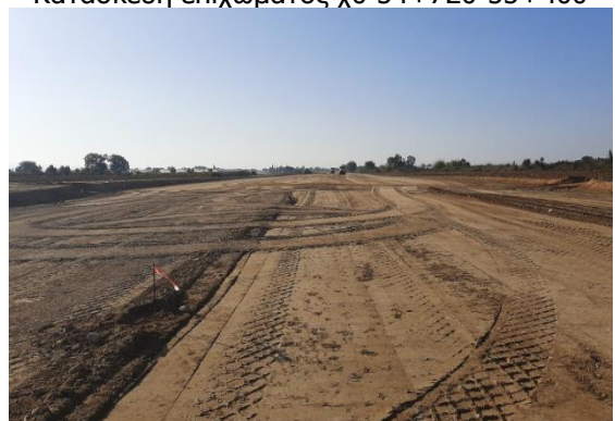
Κατασκευή επιχώματος χθ 56+000-56+600
