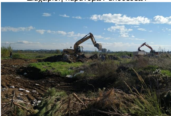
Κατασκευή επιχώματος χθ 55+400-55+780
